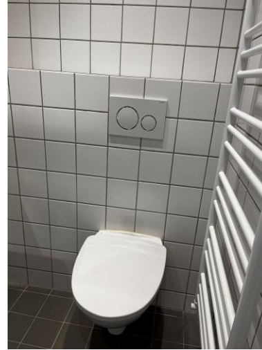
Væghængt WC med trykpanel og toiletrulleholder
